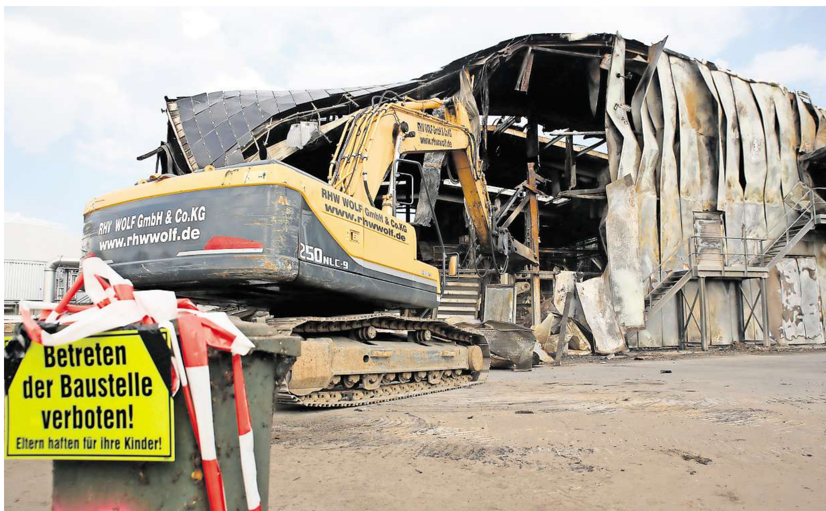
Abrissarbeiten nach dem Feuer im Kompostwerk.
