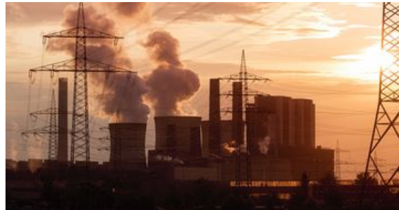
Dreckschleuder: Braunkohlekraftwerk Weisweiler Foto: Grunpfnul/S. Faber
