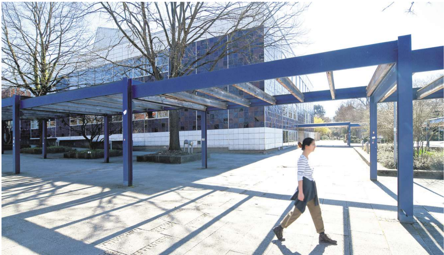
Die Diskussion um die marode Göttinger Stadthalle geht weiter, aber es zeichnet sich ab, dass sie saniert und nicht abgerissen wird.
