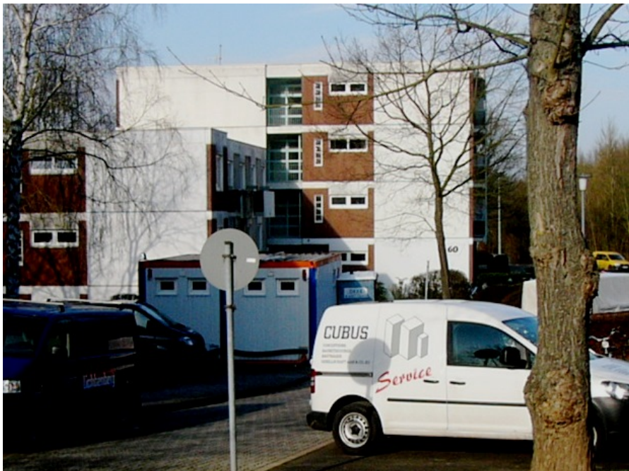
Foto vom 6.2.18 mit Cubus-Service-Wagen an der Wohnanlage.
