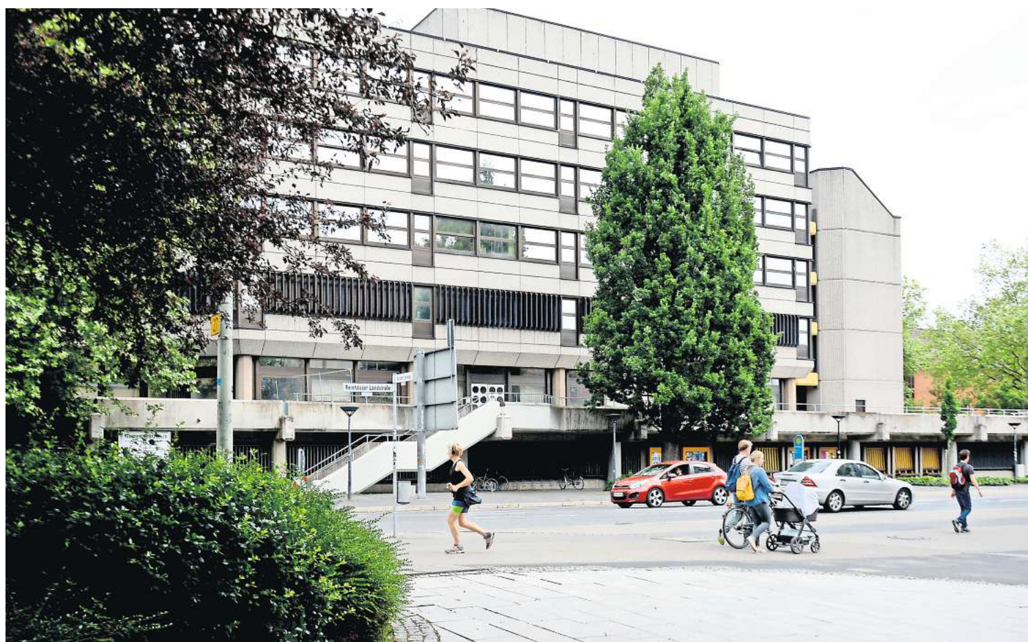
Das Neue Rathaus an der Reinhäuser Landstraße soll saniert werden. Das Stadtarchiv soll daher umziehen.
