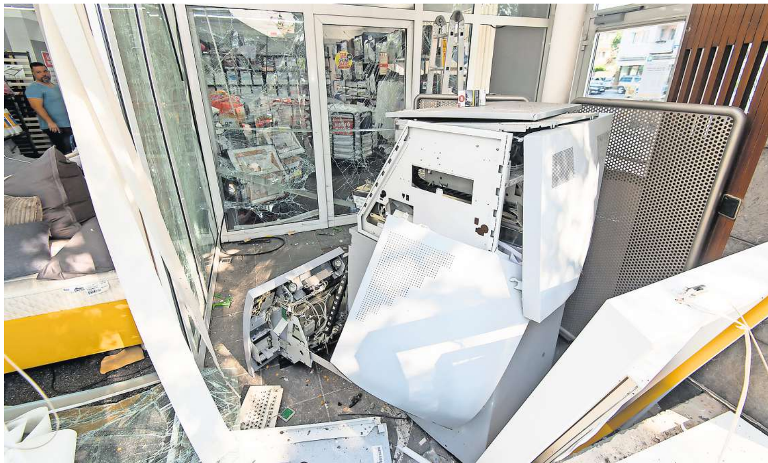
Völlig zerstört: der gesprengte Geldautomat in Weende an der Hannoverschen Landstraße.
