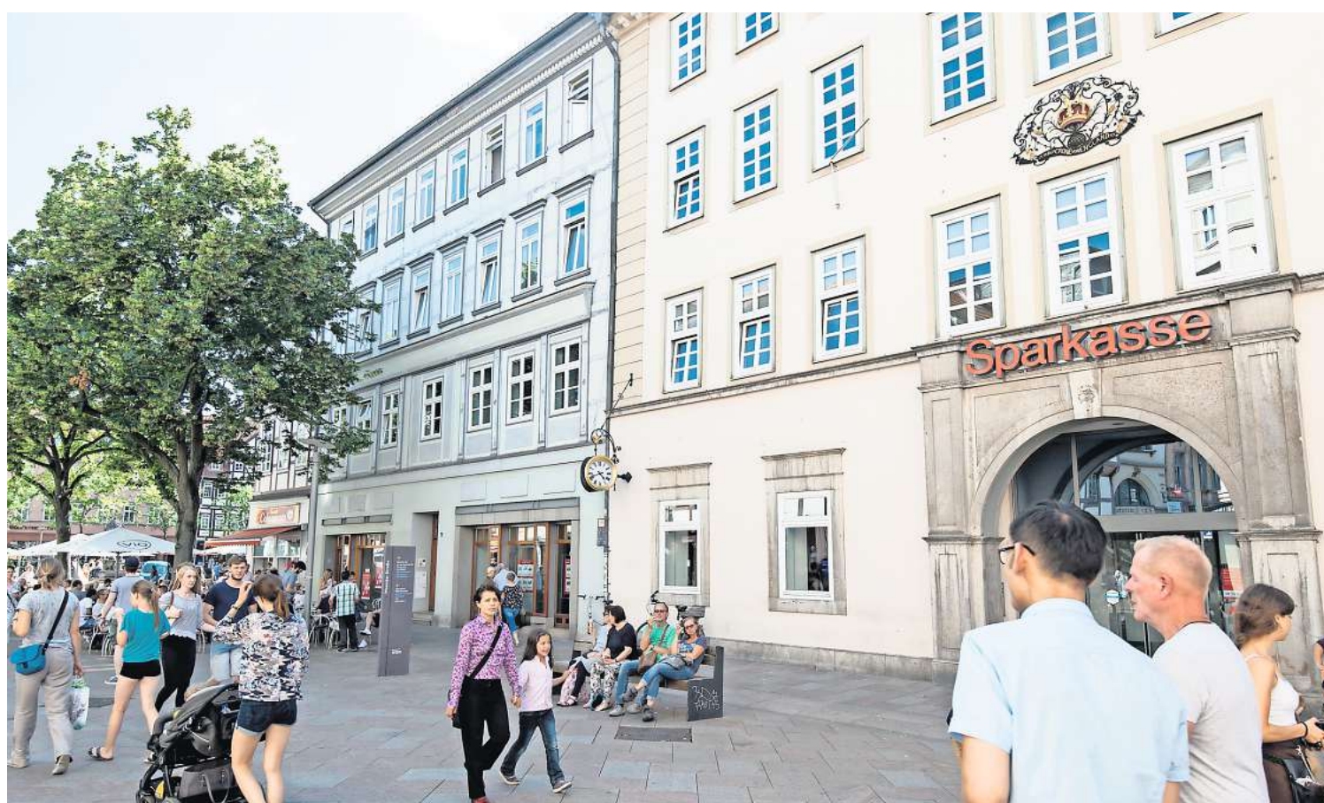
Der Gebäudekomplex der Sparkasse an der Weender Straße wird von der HT-Group aus Hildesheim übernommen und entwickelt.
