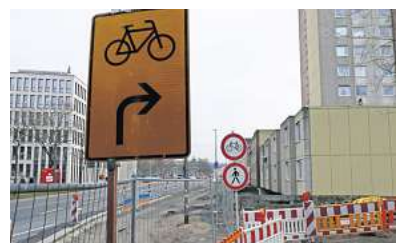
Nach wie vor für Fußgänger und Radfahrer dicht ist die Baustelle am Groner Tor. FOTO: HEIN
